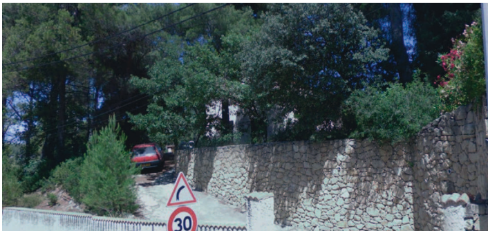
Mur de soutènement en pierre naturelle
