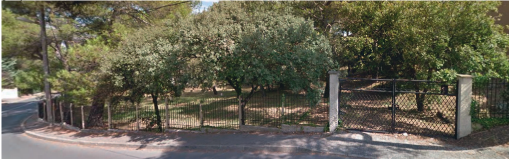
La clôture composée d'un muret très bas et d'une grille de facture simple suit la pente du terrain avec des redents réguliers et discrets
