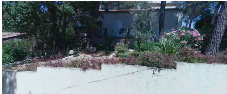
Mur de soutènement en béton lisse avec des redents discrets accompagnés de végétation
