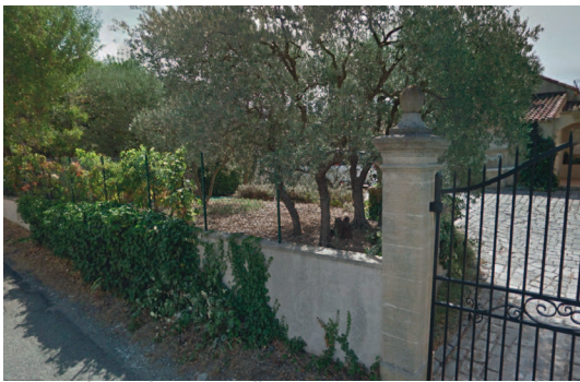
Muret enduit et clôture en grillage transparente accompagné de grimpances
