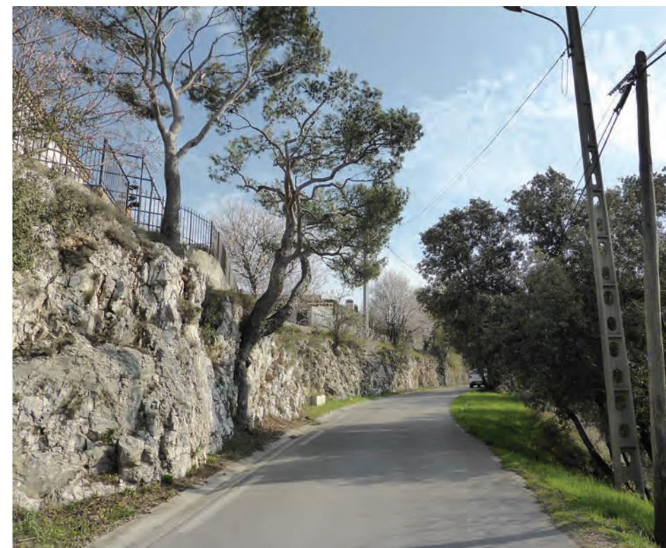
Les enrochements de l'avenue d'Aix, au niveau des terrains de sport, vue vers le sud
