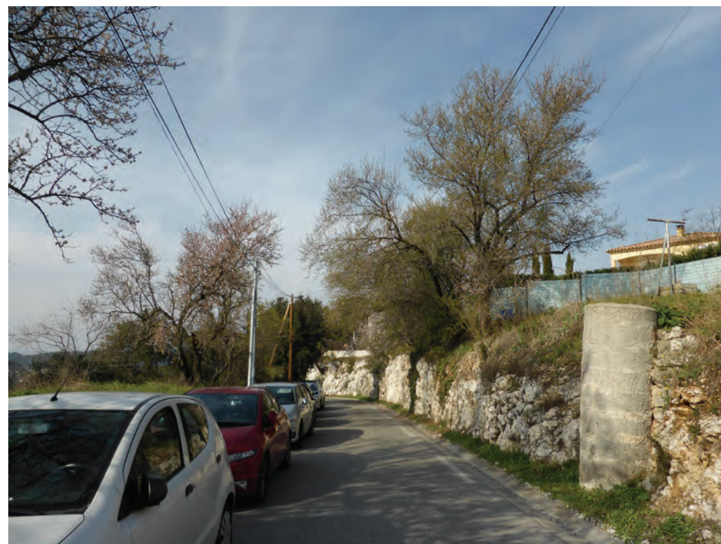
Les enrochements de l'avenue d'Aix, à proximité du village, vue vers le nord N°15.149 | MARS 2016 | CAUE13
