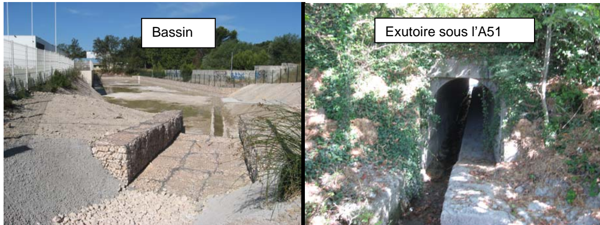
Bassin de rétention en amont de l'exutoire
