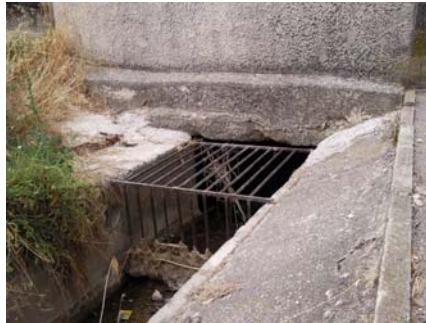
Grille en amont de la rétention enterrée
